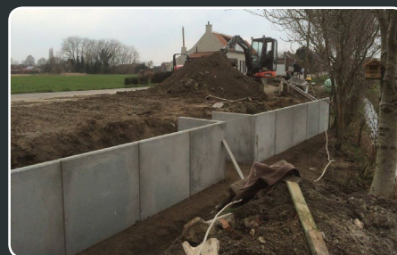
PLAATSEN VAN KEERMUREN
